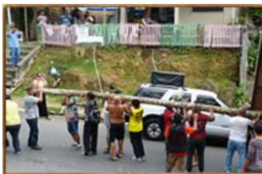
Foto 02: Levantamento do mastro
